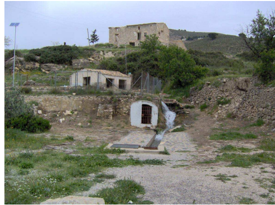
Detalle del rebosamiento del lavadero de la Fuente de Nuchet, tras un periodo lluvioso.
